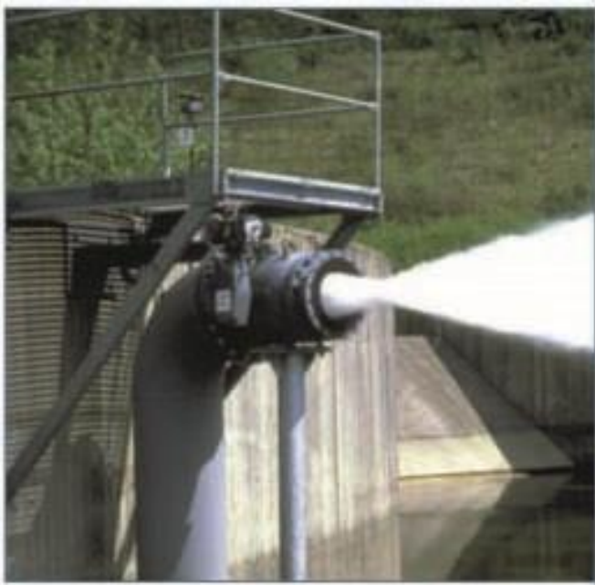
به عنوان شیر اطمینان در کنار توربین جهت باز شدن سریع
