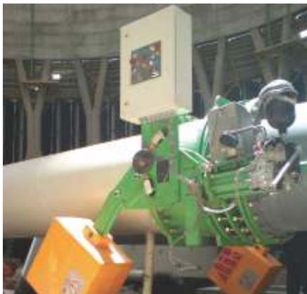
شیر سایز 1000 فشار 10 بار - نرمال بسته کاربرد: تخلیه سریع برج خنک کن پروژه: نیروگاه دماوند
