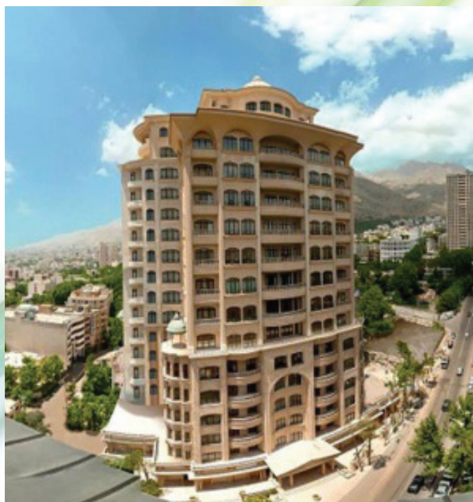
روما رزیدنس محل پروژه: تهران- خیابان کامرانیه شمالی مشخصات: ۴۷۰۰۰ مترمربع زیربنا (۱۵ طبقه) شامل ۳۲۰۰۰ مترمربع مساحت مفید واحدهای مسکونی، ۱۰۰۰ مترمربع واحدهای تجاری و ۱۴۰۰۰ مترمربع فضاهای تفریحی
