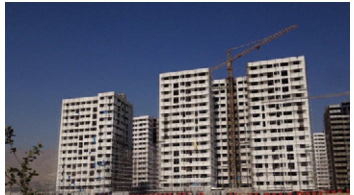
پروژه زیتون محل پروژه: بزرگراه آزادگان - شهرک گلستان - بلوار کاج - بلوار کوهک - روبروی پروژه تجاری اداری طویی ۱۵۰۰ واحد مسکونی
