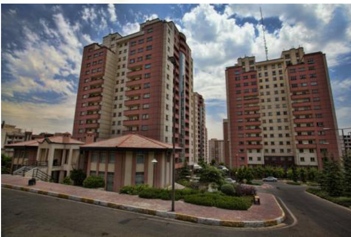
پروژه ۱۱۰۰ واحدی سبحان محل پروژه: تهران - قیطریه مشخصات: متراژ کل ۲۴۳۴۹۰ مترمربع متراژ مفید ۱۵۱۴۵۲ مترمربع - ۱۲ بلوک (۹۳۰ واحد مسکونی، ۱۳۳۸ واحد پارکینگ)
