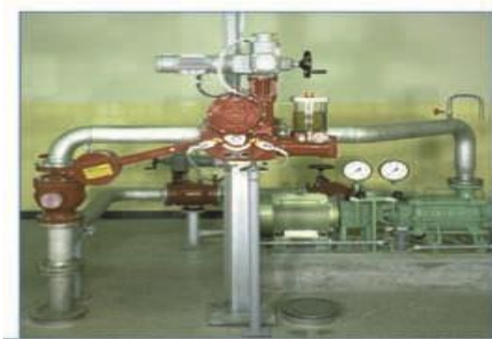
به عنوان شیر تنظیم جریان در ورودی و کنارگذر توربین ها
